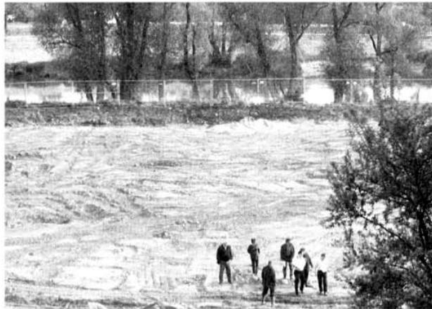
Wie geht's weiter mit der Baugrube am Unteren Wöhrd? Die Anwohner fordern eine nochmalige Diskussion. Foto: pm
